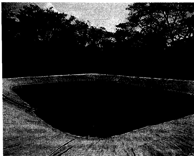
Piscina de recolección de agua para el control de polvo
