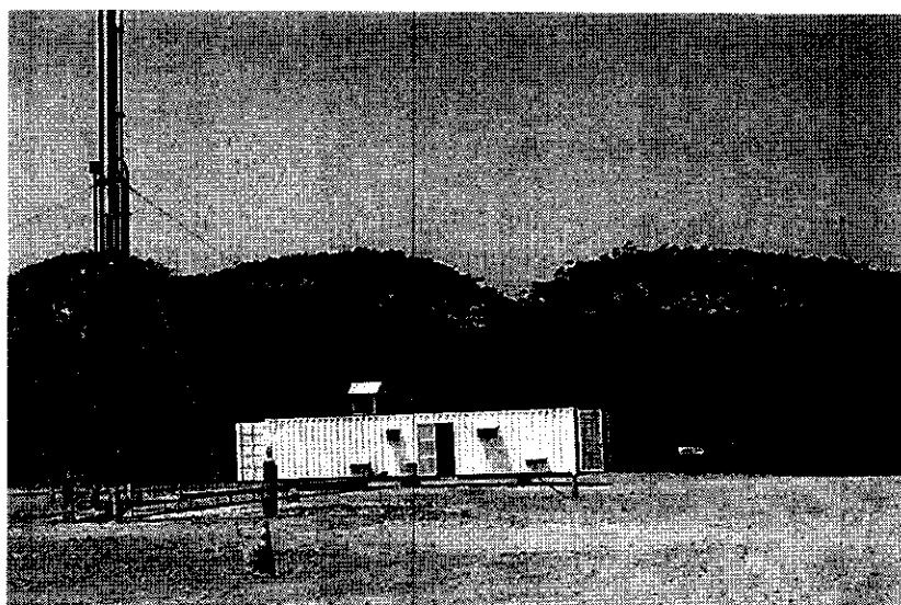
Pozo exploratorio listo para la prueba de producción
