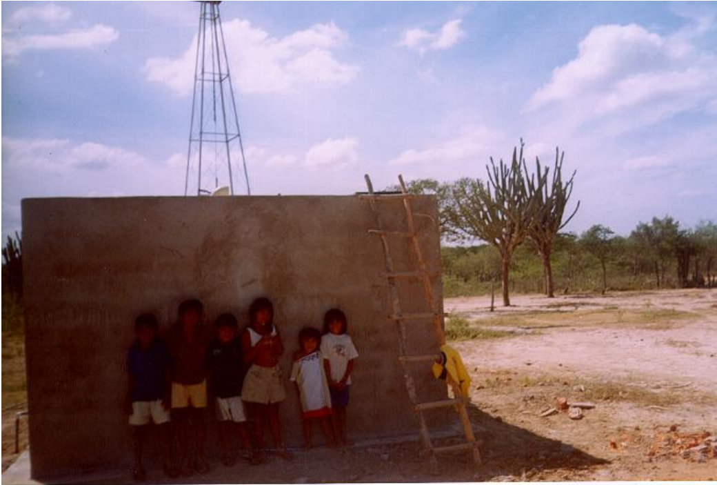
Figura 28. Sistemas de abastecimiento de agua de la Comunidad Indígena.
