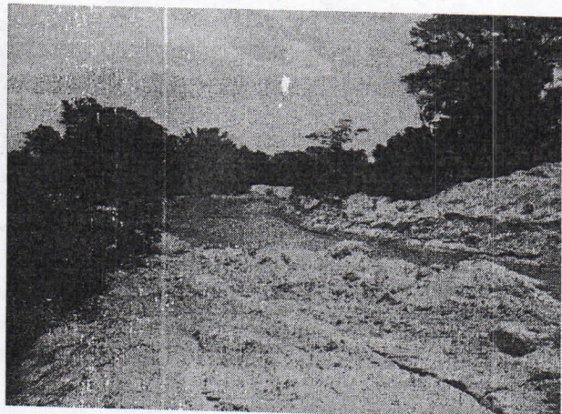
Imagen 24. Socavación y canalización del río
