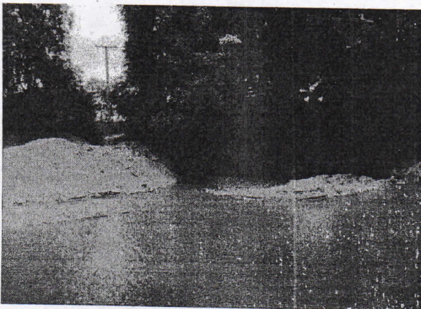
Imagen 19. Recaba y terraplenes en el lecho del río
