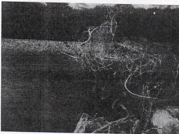
Imagen 13. Obstrucción del cauce por árbol caído
