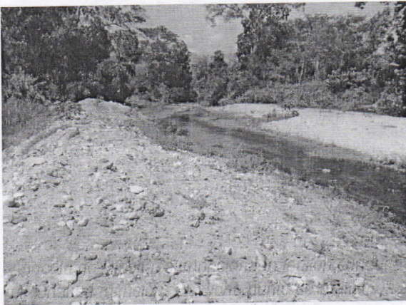
Imagen 7. Jarillón sobre el cauce del río Lagarto
