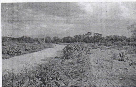
Imagen 22. Cauce canalizado dentro del predio El Cequión
