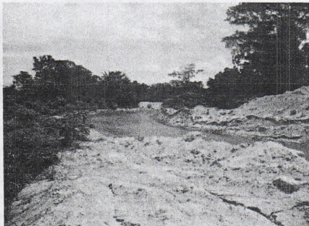
Imagen 24. Socavación y canalización del río
