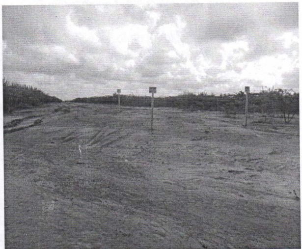
Imagen 6. Panorámica de un área ya intervenida
