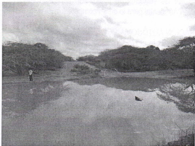
Imagen 1. Intersección del cauce y el gasoducto
