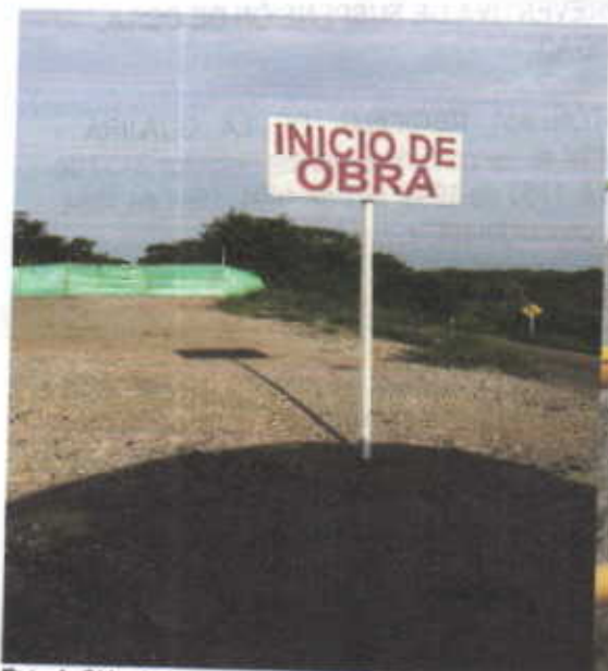
Foto 1. Sitio de la obra.
