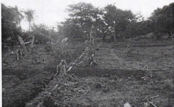
Imagen 4. Excavaciones para instalación tubería riego
