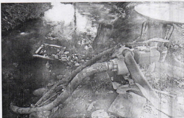
Imagen 1. Punto propuesto para la captación
