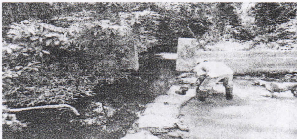
Imagen 13. Captación Nefer Choles
