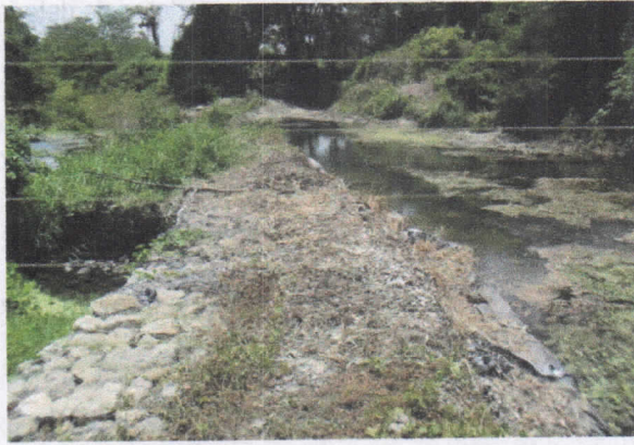
Imagen 21. Dique con gaviones y concreto
