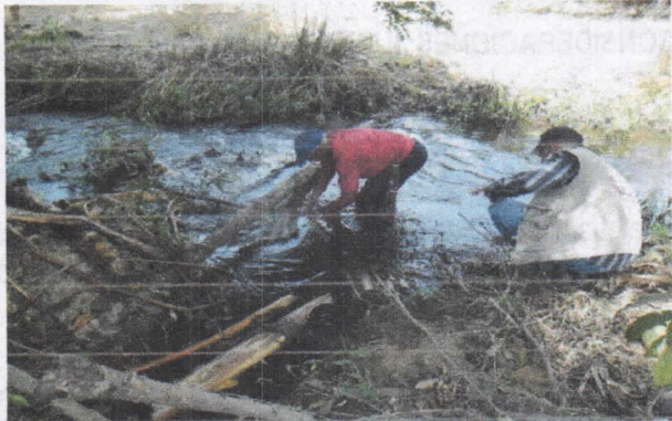
Imagen 19. Destrucción de trincho con lata de zin
