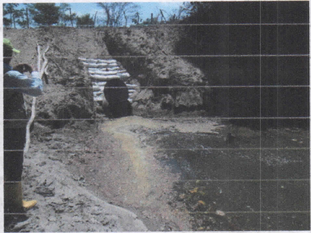
Imagen 13. Adecuación de nueva captación
