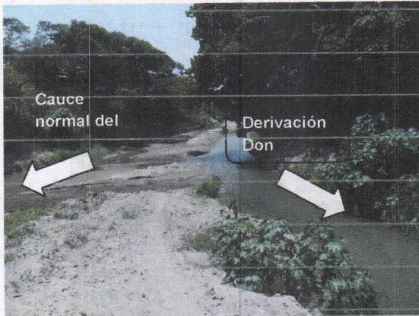
Imagen 9. Captación sobre el río Tapias
