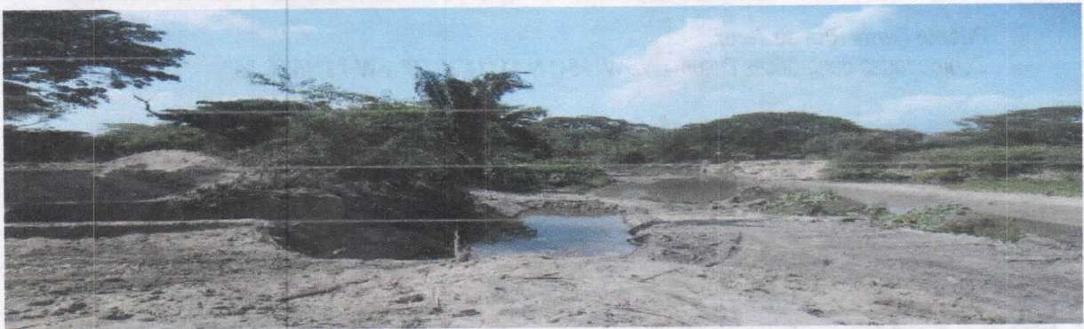
Imagen 11. Intervención de cauce margen derecha
