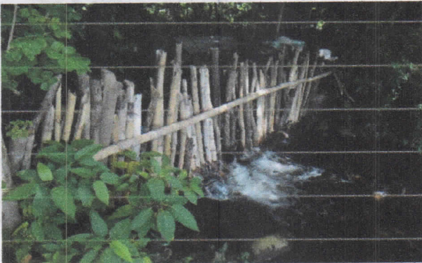
Imagen 15. Derivación Margen izquierda
