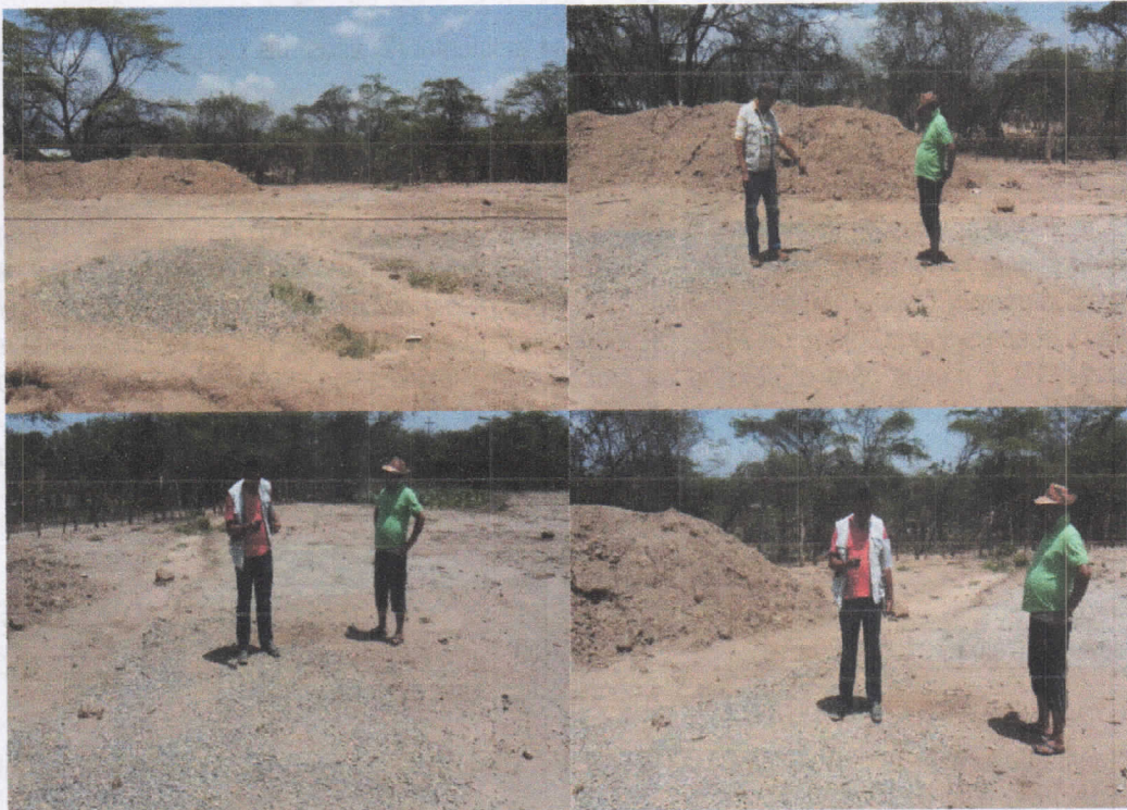
Foto 1, 2, 3, 4; Sitio de la perforación señalado.
